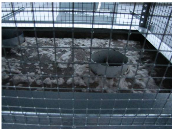
Joonis 5.15 Ventilatsioonikorstnaid katva pleki alapinnale kondenseerunud vesi on täielikult märjanud soojustuse (vasakul) ning soojuskandja defektne isolatsioon (paremal).
