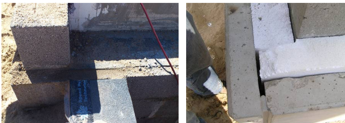
Joonis 3.3 Kriitilise tähtsusega hoone horisontaalse läbilõikava hüdroisolatsiooni paigaldusvead maksavad hiljem kurjalt kätte, kuna neid pärast parandada on väga probleemne (vasakul). Pilud soojustuse vahel, soojustus ei ole kinnitatud tarindisse korralikult (paremal).
