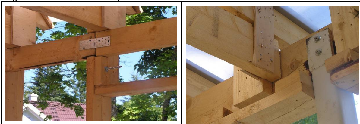
Joonis 3.11 Lagunemisohtlik ja valesti koostatud puitprussliide (vasakul). Katuse koormuste ülekandmine ühelt puitdetaililt teisele ja sealt edasi toimub ebakindlalt (läbi lippidest ja lappidest kaadervärgi) (paremal).
