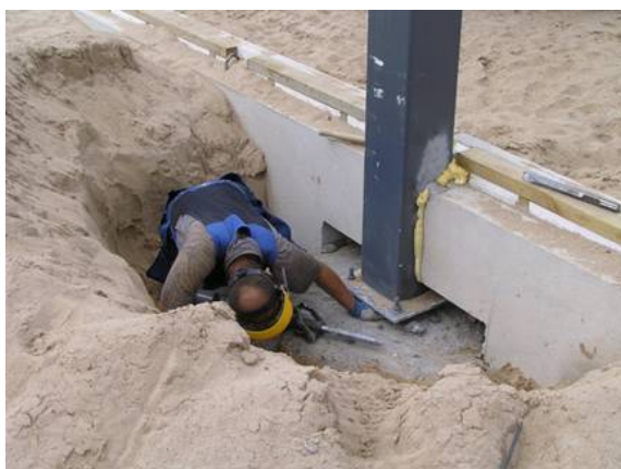
Joonis 3.5 Ei kontrollitud posti asendit õigeaegselt, tuleb lahti piigata ja uuesti reguleerida (vasakul). Esineb toetuspikkuste hälbeid ja toepinna kaldumist raskuse pealepanekul (riivtala ei ole alt toetatud) (paremal).
