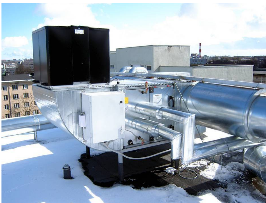
Joonis 12.2 Ventilatsiooni keskseade.
