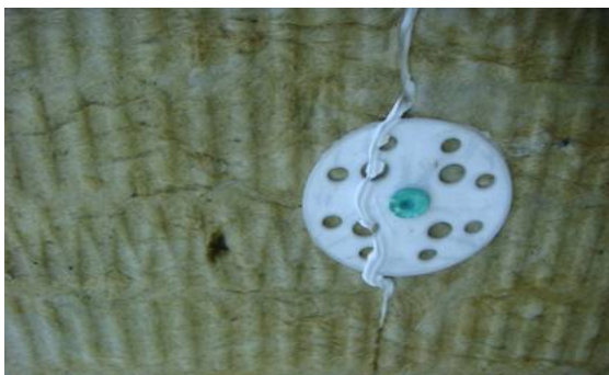
Joonis 3.13 Tuuletõkke tihendamine kohalikul moel, silikooni või vuugivahuga
