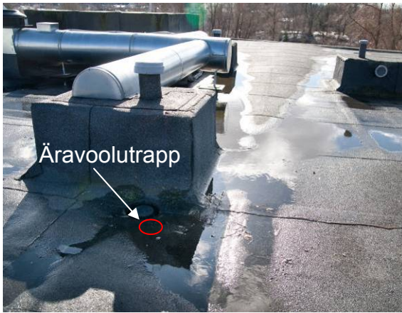
Joonis 5.12 Kallete projekteerimisel pole arvesse võetud ventilatsioonišahti ning vesi ei pääse trapini (vasakul), otse trapi kohale paigaldatud madal suure läbimõõduga ventilatsioonitoru teeb trapi hooldamise keeruliseks (paremal)
