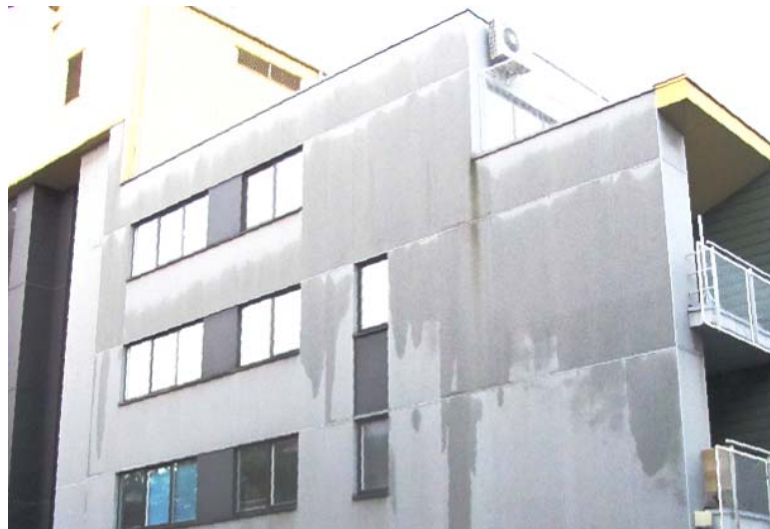
Joonis 5.36 Plaatfassaadi pinnale tekib kiiresti allavalguva vee kelme.
