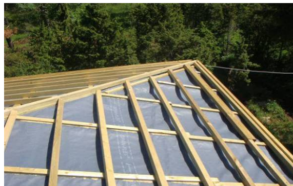
Joonis 3.16 SBS-katte keevitamine lamekatusele, kus soojustus ja kate tüübeldatakse läbi paani serva, kasutusel on impregneerimata pinnaga kõvavillplaat, küsimuseks jääb vettpidava külgülekatte laius (vasakul); kaldharjaga katusele, kus kelpkatustel puudub harja- ja otsaviilutuulutus (paremal).
