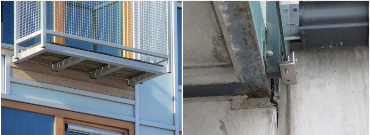
Joonis 5.23 Läbi fassaadikatte olevad horisontaalsed rõdudalad võimaldavad sademevee sattumist fassaadi taha seina.
