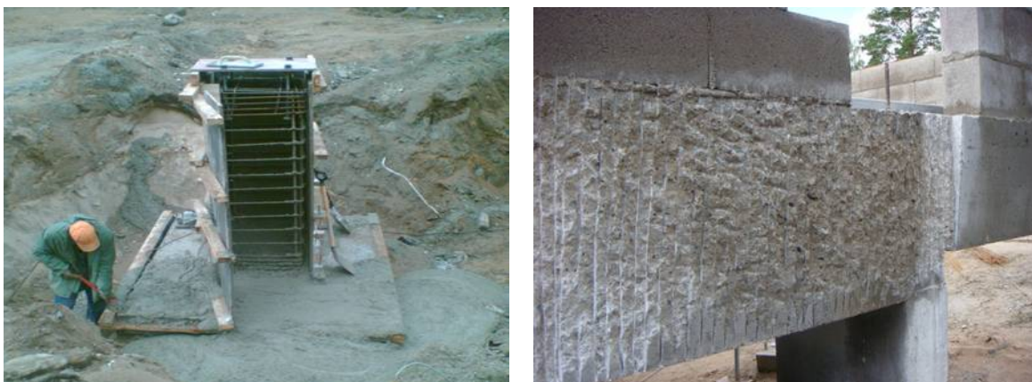
Joonis 3.2 Laiali läinud kohalvalmistatud puitraketis (vasakul) ja laiali läinud raketise tõttu piikamisega kahjustatud betoontarind (paremal).
