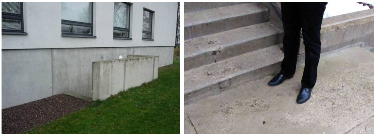
Joonis 5.3 Sademetele avatud trepikäikudesse kogunevad sademed ja on takistatud vee aurustumine ja kuivamine. Piirdekonstruktsiooni märgumine ja vee tungimine sokli kaudu hoonesse, halvemal juhul kahjustub vundamendi- ja soklibetoonkonstruktsioon. Betooni külmakindlus on horisontaalpindadele mittevastava betooni klassi ja/või jääsulatusaine kasutamise tõttu ammendunud (paremal).
