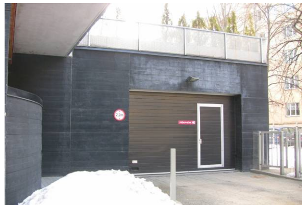
Joonis 5.19 Sademetele avatud ülemise korruse rõdult toimus vee läbijooks alumise korruse korterisse (vasakul). Põhjuseks katuse puudumine ja puudulikult või valesi tehtud hüdroisolatsioon. Tumedal betoonipinnal on näha veekahjustust ja betooni koostisesse kuuluva kaltsiumhüdroksiidi ehk kustutatud lubja ( \text{Ca}(\text{OH})_2 ) väljapesemisest tulenevaid valgeid jälgi, mis viitavad betooni alanud kahjustustele (paremal). Kahjustused on nii betoonist \text{Ca}(\text{OH})_2 väljapesemine kui ka märjalt külmumine. Samas võib oletada ka varem või hiljem toimuvat vee tungimist garaažidesse lae kaudu. Põhjuseks vee allavoolamine avatud eenduvalt horisontaalpinnalt.
