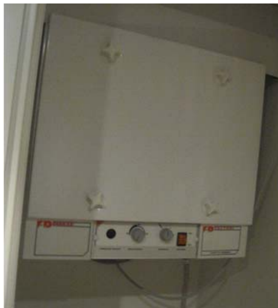
Joonis 11.3 Näide plaatsoojusvahetiga korteri ventilatsiooniagregaadist.
