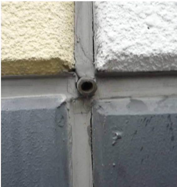
Joonis 5.25 Suurpaneelhitiste probleemiks on vuukide teostus, nt on vuugimastiks kaotanud nakke betooni pinnaga, kuna see on kaetud värvikihiga. Samuti külmasillad ning lahtiste, ilmastikule avatud rõdude kaitse sademete eest. Kindlasti ei tohiks sellistel hoonetel puududa sokliäärne sillutusriba. Sokli märgumine ja vee tungimine keldrisse on nimetatud juhul obligatoorne. Rõdude klaasimine parandab oluliselt hoone seisundit.
