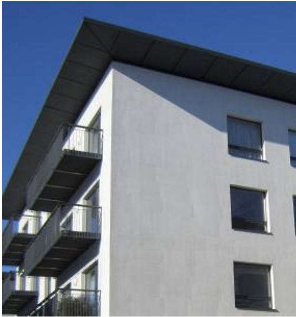
Joonis 5.16 Krohvitud fassaad on kaitstud ülalt pealevoolava veega märgumise eest laia räästaga väikese kaldega katusega. Samuti vähendab lai räästas kaldvihma fassaadi ülaosale. Krohvikahjustused puuduvad. Veest tingitud kahjustusi esineb materjalide kokkupuutepinnal, kus suure veeimavusega rõhtne puidust rõduserv on põhjustanud fassaadil plekke, seega ka märgumist.
