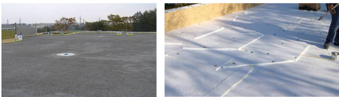
Joonis 3.15 Kalde ehitamine lamekatusele keramsiitbetoonist enne katuse soojustuskihtide ja katusekatte paigaldust. Katusekate tüübeldatakse kaldekihti, ei lõhuta selle all olevat aurutõket, kuid tegija peab kasutama spetsiaalseid tüübleid ja oskama keramsiitbetoonitöid (vasakul). Kalde ehitamine lamekatusele soojustusmaterjalist, kus puudub tuulutust, tuginedes kattematerjali tootja hinnangule, et antud materjal tuulutust ei vaja (paremal).
