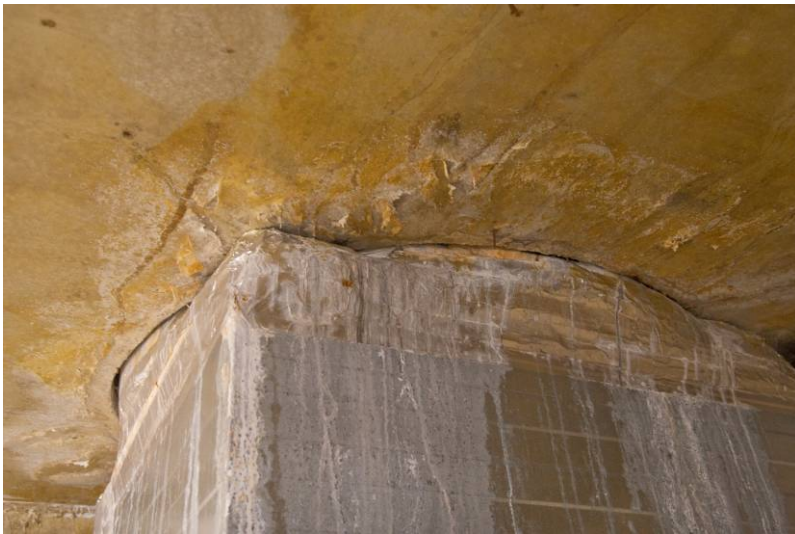
Joonis 5.5 ~10 aastat eksploatatsioonis olnud hüdroisolatsiooni hiljutine leke (vasakul) ventilatsioonikorstna läbiviigust (paremal) näitab, et lahenduse pikaajalist toimivust ei saa hinnata kõigest paariaastase kasutuse järel.
