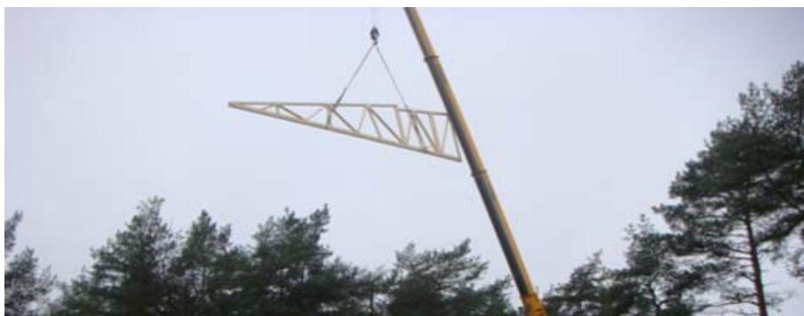
Joonis 3.12 Puitfermi tõstmisel jaotuvad sisejõud fermis ümber ja võivad kahjustada toodet.
