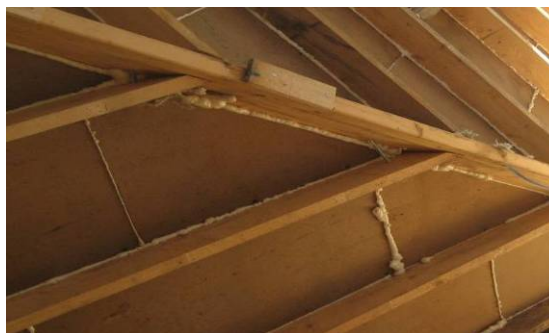
Joonis 3.13 Tuuletõkke tihendamine kohalikul moel, silikooni või vuugivahuga
