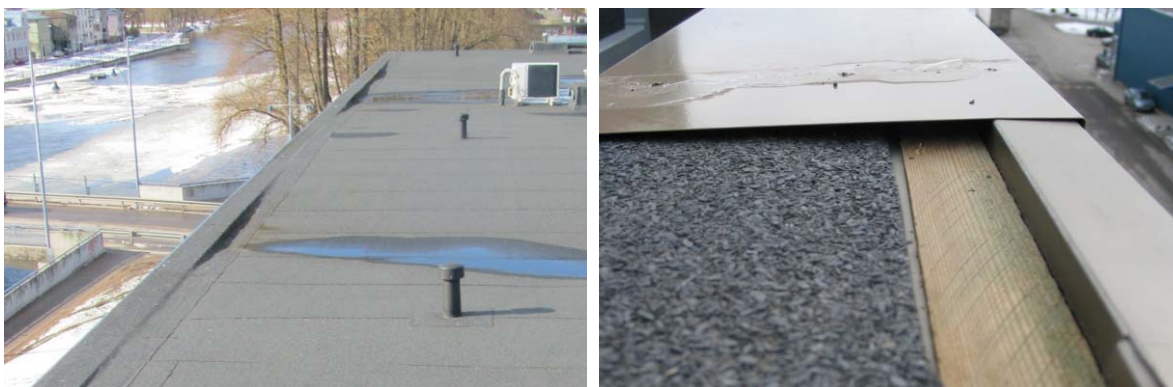
Joonis 5.10 Liiga väike katusekalle, parapeti ja piirde puudumine (vasakul) ja liiga väikese kaldega parapetiplekk (paremal).
