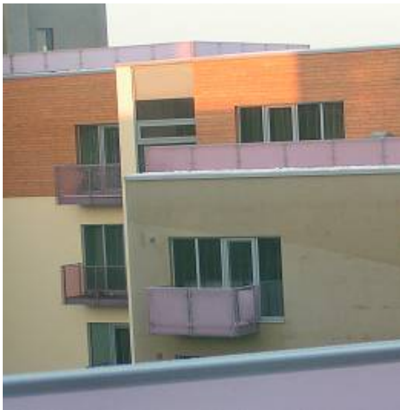
Joonis 5.17 Lamekatus ja avatud rõdud, mille põrandat katab puitlaudis. Märgunud krohv seinal ja rõdude läbivettinud kahjustatud puitpõrand viitavad mittesobivate materjalide kasutamisele või vastupidi, nii katuse kui ka rõdude konstruktsioon tingiks praegusest erinevate materjalide kasutamist.
