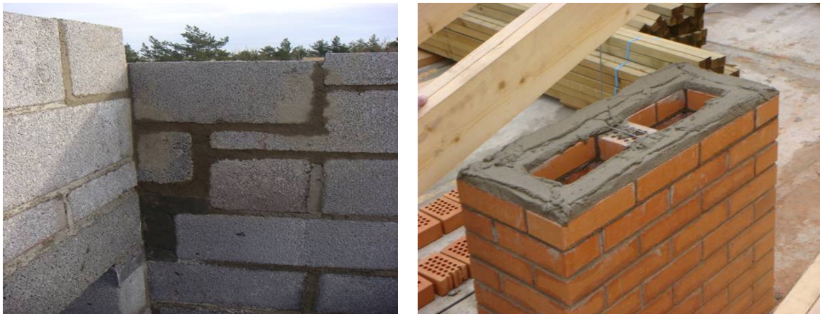
Joonis 3.10 Seotiste ja kiviplitükide väär kasutamine müüris (vasakul). Korstna ladumisel tuleb täpselt järgida õiget materjalivalikut ja -kasutamist korstna erinevates osades (paremal).
