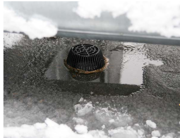
Joonis 5.12 Kallete projekteerimisel pole arvesse võetud ventilatsioonišahti ning vesi ei pääse trapini (vasakul), otse trapi kohale paigaldatud madal suure läbimõõduga ventilatsioonitoru teeb trapi hooldamise keeruliseks (paremal)
