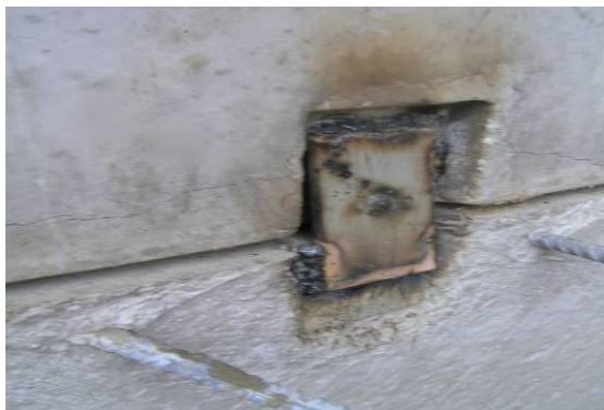
Joonis 3.9 Platsikeevituste kvaliteet jätab sageli soovida ja võib osutada ohtlikuks veaks (vasakul). Pildil ühe kesise keevitaja poolt mitmeid kordi üle keevitatud tarilapp. Vuukimise eel korralikult ettevalmistamata vuuk, paremal näha, et vuugimass on juba sisse kantud (paremal).
