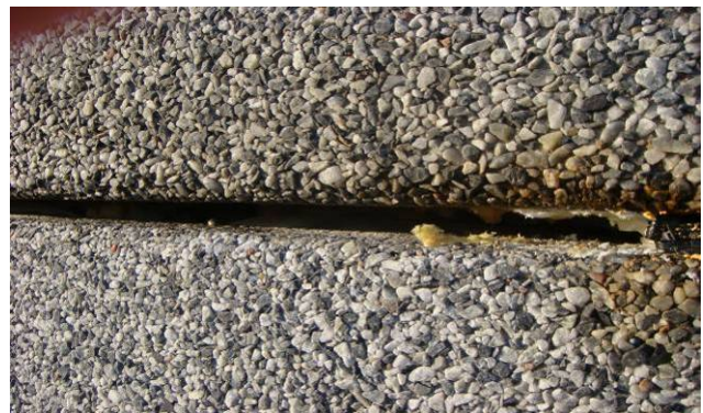
Joonis 3.9 Platsikeevituste kvaliteet jätab sageli soovida ja võib osutada ohtlikuks veaks (vasakul). Pildil ühe kesise keevitaja poolt mitmeid kordi üle keevitatud tarilapp. Vuukimise eel korralikult ettevalmistamata vuuk, paremal näha, et vuugimass on juba sisse kantud (paremal).
