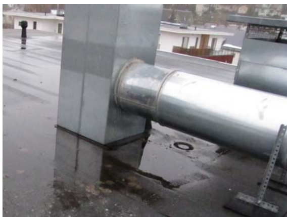
Joonis 5.13 Vee puudulik äravool trappi, puuduvad piirded ja pollarid (vasakul) ning tuulutuskorstna puudulik liitumine peakanaliga (paremal)
