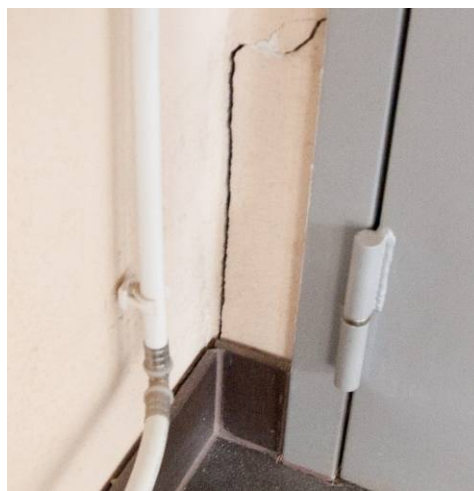
Joonis 5.42 Pragu materjalide liitekohas tulenevalt koormusest (vasakul) ja vajumispragu trepikoja ning korteri vahelises seinas mõjutab potentsiaalselt tarindi õhu- ja helipidavust ning tulepüsivust (tiheduskriteerium E).
