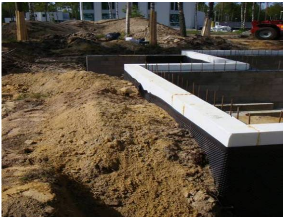
Joonis 3.4 Liiga paks tagastäitekiht, olemasolev pinnas dreniva liiva asemel (vasakul); valesti valmistatud seinapaneelid (paremal).
