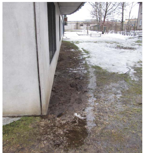
Joonis 5.6 Äravajunud pinnas sademeveekaevu ümber (vasakul). Hooneümbruse kalle on hoone poole, juhtides pinnaveed hoone poole (paremal).
