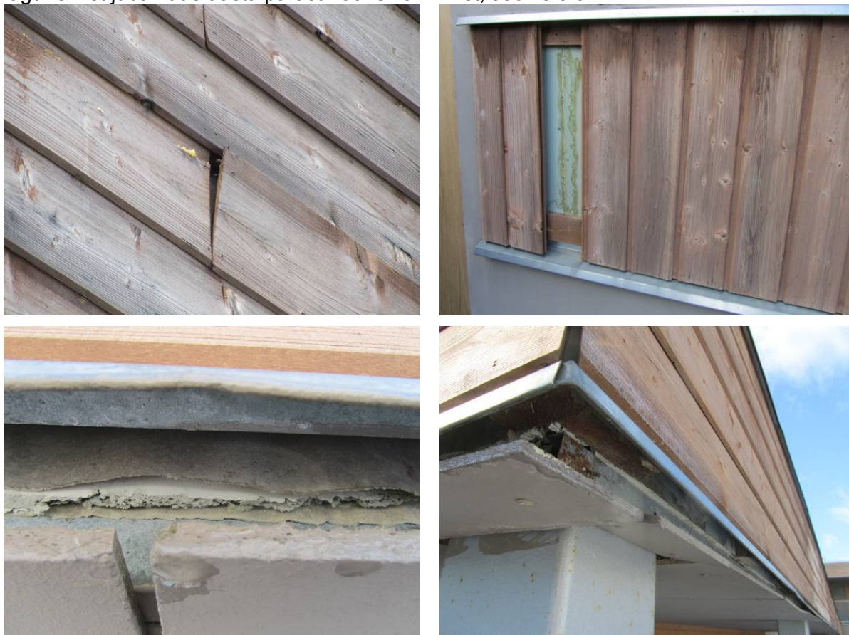
Joonis 5.32 Laudvoodri taga tuuletõkkeplaadiks kasutatud kipsplaat on lagunenenud juba kuue aastaga. Antud juhul on tuulutusvahe on alt ja ülevalt suletud kuid kipsplaadi kasutamine ei näita olema kestav lahendus ka tuulutatava voodri korral.
