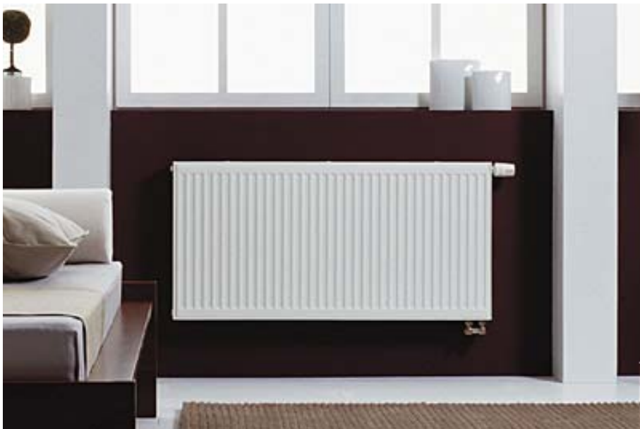
Joonis 10.3 Näide enamikes korterites kasutatavast plaatradiaatorist.
