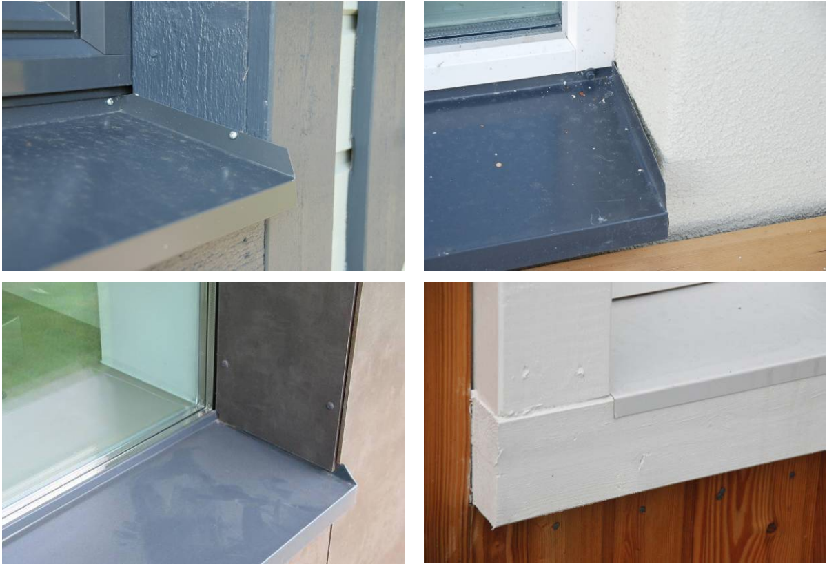
Joonis 5.40 Ehituslikult riskantsed veeplekilahendused akna ja seina liitumises.
