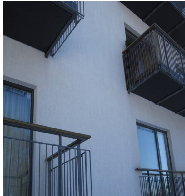
Joonis 5.16 Krohvitud fassaad on kaitstud ülalt pealevoolava veega märgumise eest laia räästaga väikese kaldega katusega. Samuti vähendab lai räästas kaldvihma fassaadi ülaosale. Krohvikahjustused puuduvad. Veest tingitud kahjustusi esineb materjalide kokkupuutepinnal, kus suure veeimavusega rõhtne puidust rõduserv on põhjustanud fassaadil plekke, seega ka märgumist.
