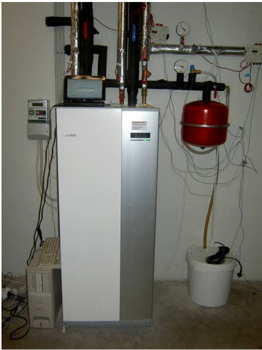
Joonis 12.3 Soojuspump (vasakul) ja tarbevee akumulatsioonipaak (paremal).
