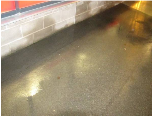
Joonis 5.4 Märg ja vett läbilaskev väikeplokk-sokkel ja märgjad põrandad hoone sees.
