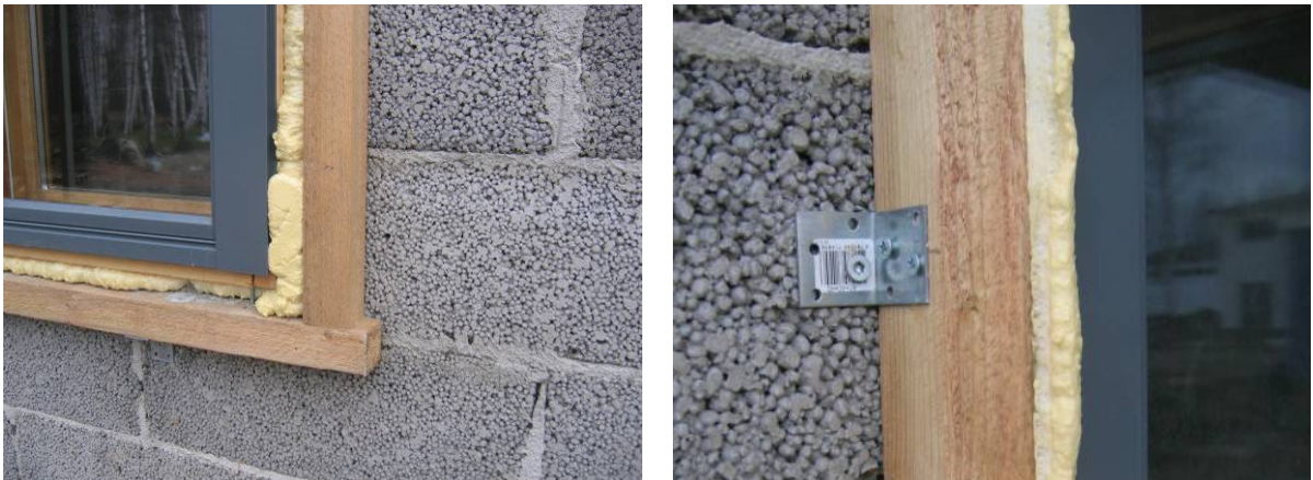
Joonis 5.41 Akna paigaldusraami ja seina vahe on tihendamata. Lahendus ei taga liitekohta õhupidavust.
