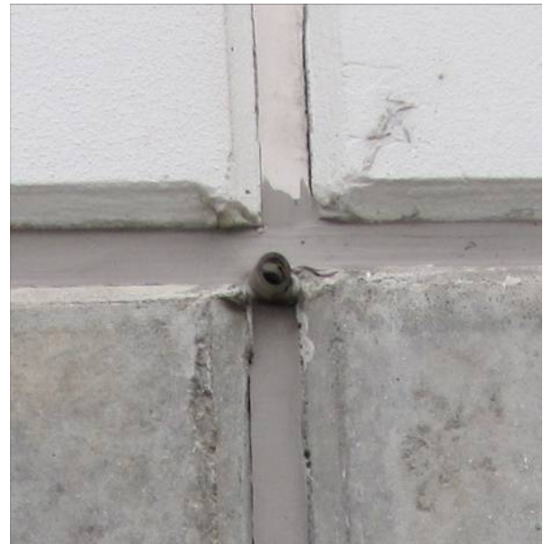
Joonis 5.25 Suurpaneelhitiste probleemiks on vuukide teostus, nt on vuugimastiks kaotanud nakke betooni pinnaga, kuna see on kaetud värvikihiga. Samuti külmasillad ning lahtiste, ilmastikule avatud rõdude kaitse sademete eest. Kindlasti ei tohiks sellistel hoonetel puududa sokliäärne sillutusriba. Sokli märgumine ja vee tungimine keldrisse on nimetatud juhul obligatoorne. Rõdude klaasimine parandab oluliselt hoone seisundit.
