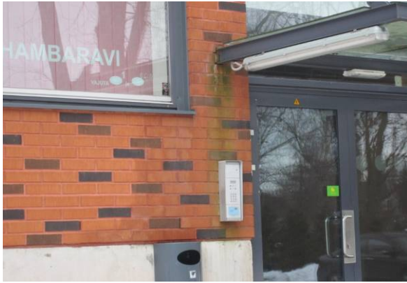
Joonis 5.20 Kaldeta varikatuselt allavoolav vesi põhjustab fassaadimüüritise ulatuslikku märgumist ja kahjustusi (vasakul). Konsoolsete avatud rõdude betoon märgub (paremal). Põrandale kantud polümeerne katematerjal märjal betoonil neis tingimustes ei püsi.
