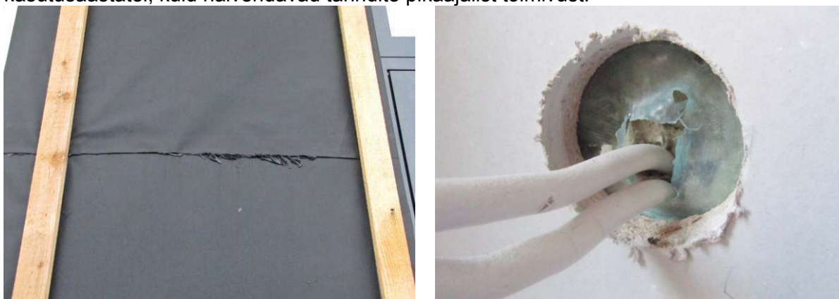
Joonis 5.34 Riskantsed ja lubamatud lahendused puitsõrestikseintel: tuuletõkkeks tuuletõkkepaber ja selle tihendamata liitekoht (vasakul). Elektriikaablite läbiviik õhu- ja aurutõkkelilest (paremal).
