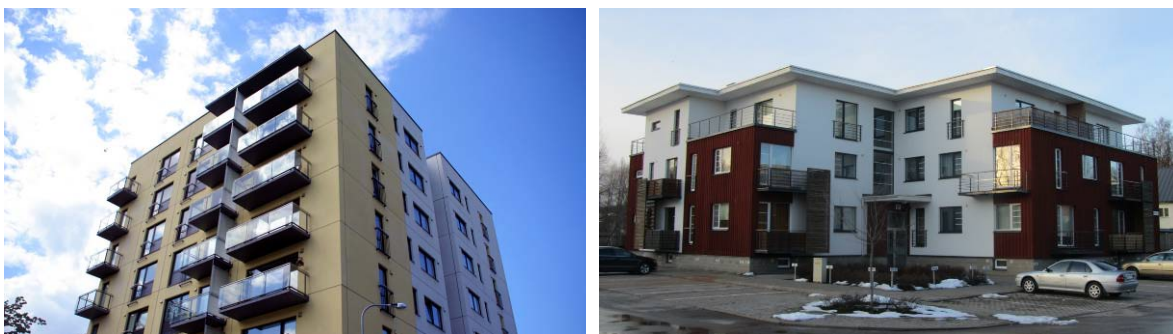
Joonis 5.9 Tüüpiline katuse lahendus: räästata lamekatuselagi (vasakul). Räästaga varustatud hooneid on üksikuid (paremal).
