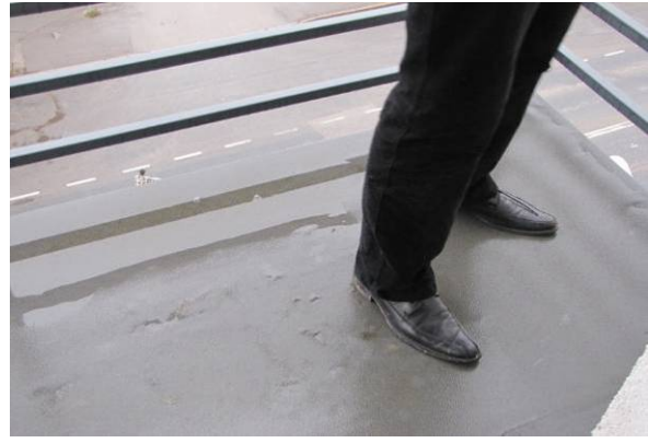
Joonis 5.20 Kaldeta varikatuselt allavoolav vesi põhjustab fassaadimüüritise ulatuslikku märgumist ja kahjustusi (vasakul). Konsoolsete avatud rõdude betoon märgub (paremal). Põrandale kantud polümeerne katematerjal märjal betoonil neis tingimustes ei püsi.
