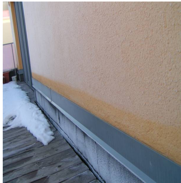
Joonis 5.17 Lamekatus ja avatud rõdud, mille põrandat katab puitlaudis. Märgunud krohv seinal ja rõdude läbivettinud kahjustatud puitpõrand viitavad mittesobivate materjalide kasutamisele või vastupidi, nii katuse kui ka rõdude konstruktsioon tingiks praegusest erinevate materjalide kasutamist.
