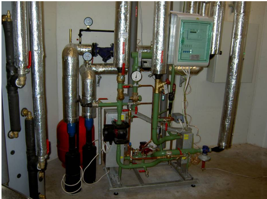
Joonis 12.1 Hoone soojuskeskus.
