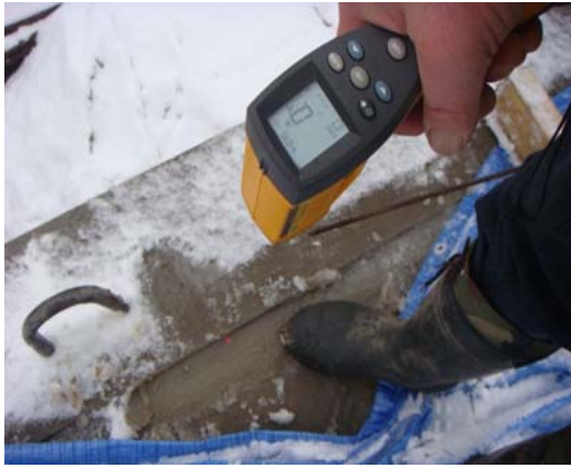
Joonis 3.6 Ebasobiv temperatuur (miinuskraadi oht) monoliitimisbetooni kivistamiseks (vasakul). Paneeli monolitiseeringute enneaegne koormamine (paremal).
