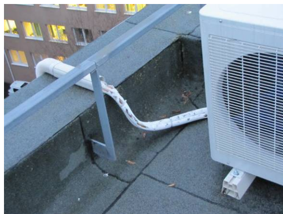
Joonis 5.15 Ventilatsioonikorstnaid katva pleki alapinnale kondenseerunud vesi on täielikult märjanud soojustuse (vasakul) ning soojuskandja defektne isolatsioon (paremal).
