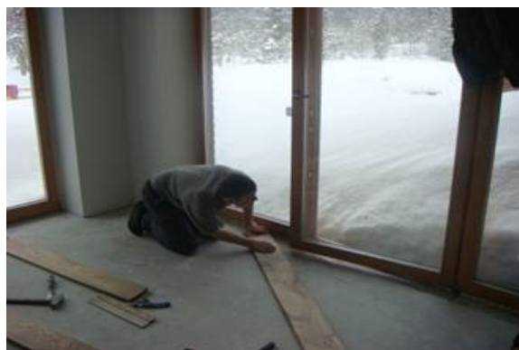
Joonis 3.17 Prussraam avatäite paigalduseks pole projekteeritud, vaid kohapeal ehitaja poolt lahendatud kinnitused (vasakul); üllatused pörandakatte paigaldusel: aken ei käi lahti (paremal).
