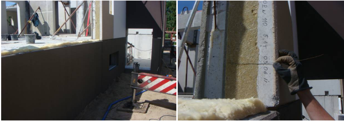
Joonis 3.8 Kihtpaneelide vuukide soojustused viiakse montaažil kokku vahele asetatava villaribaga. Monoliitimisel võib juhtuda et vertikaalsete vuukide soojustuste vahele jääv riba lükatakse ära ja pilu täitub betooniga.
