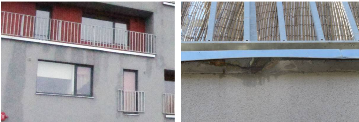
Joonis 5.24 Fassaadi kahjustus hüdroisolatsiooni lekkimise rõdu piirdepostide kinnituse juurest.
