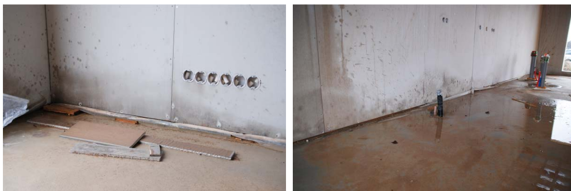
Joonis 5.33 Niiskusturvalisusreeglite jäme rikkumine puitsõrestikseinte ehitusel. Ehitusmaterjalid ei tohi ehituse ajal märjaks saada.
