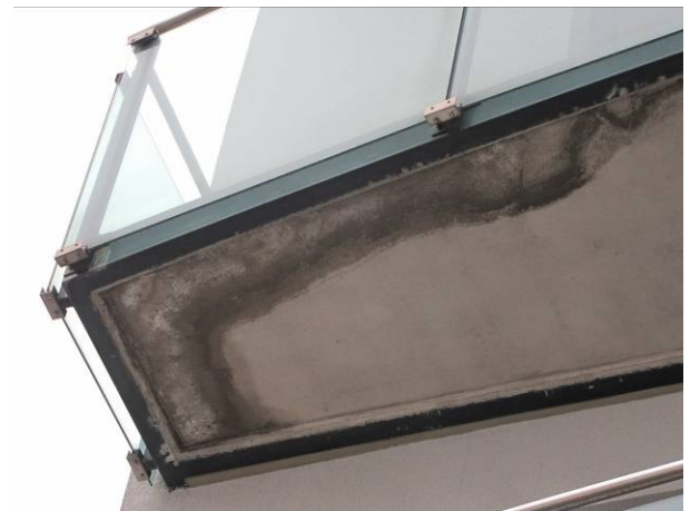
Joonis 5.22 Valesti lahendatud vee äravool rõdudelt märgab fassaadi ja põhjustab rõduplaadi korrosiooni.
