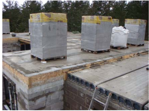
Joonis 3.6 Ebasobiv temperatuur (miinuskraadi oht) monoliitimisbetooni kivistamiseks (vasakul). Paneeli monolitiseeringute enneaegne koormamine (paremal).
