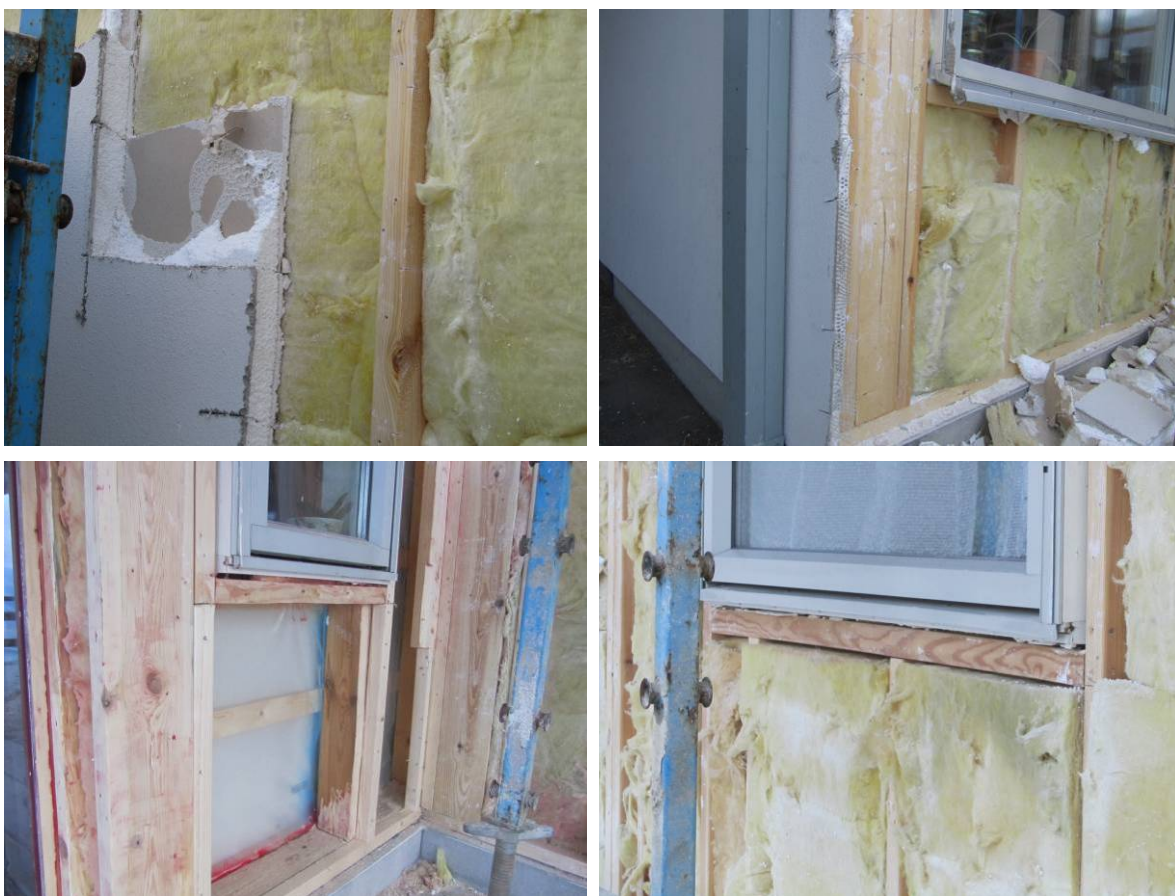
Joonis 5.30 Krohvitud komposiitsoojustus puitsõrestikseinal on riskitarind. Toimivusprobleeme on tuvastatud nii Ameerikas, Põhjamaades kui ka Eestis.
