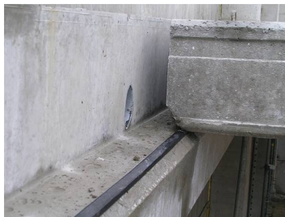
Joonis 3.5 Ei kontrollitud posti asendit õigeaegselt, tuleb lahti piigata ja uuesti reguleerida (vasakul). Esineb toetuspikkuste hälbeid ja toepinna kaldumist raskuse pealepanekul (riivtala ei ole alt toetatud) (paremal).
