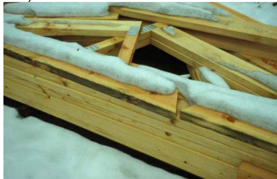
Joonis 3.1 Korras- ja hoolimatus ehitusplatsil kandub kahjustada saanud materjalide kaudu üle ka ehitisse ja mõjutab selle kestvust (nii otseselt kui ka kaudselt).
