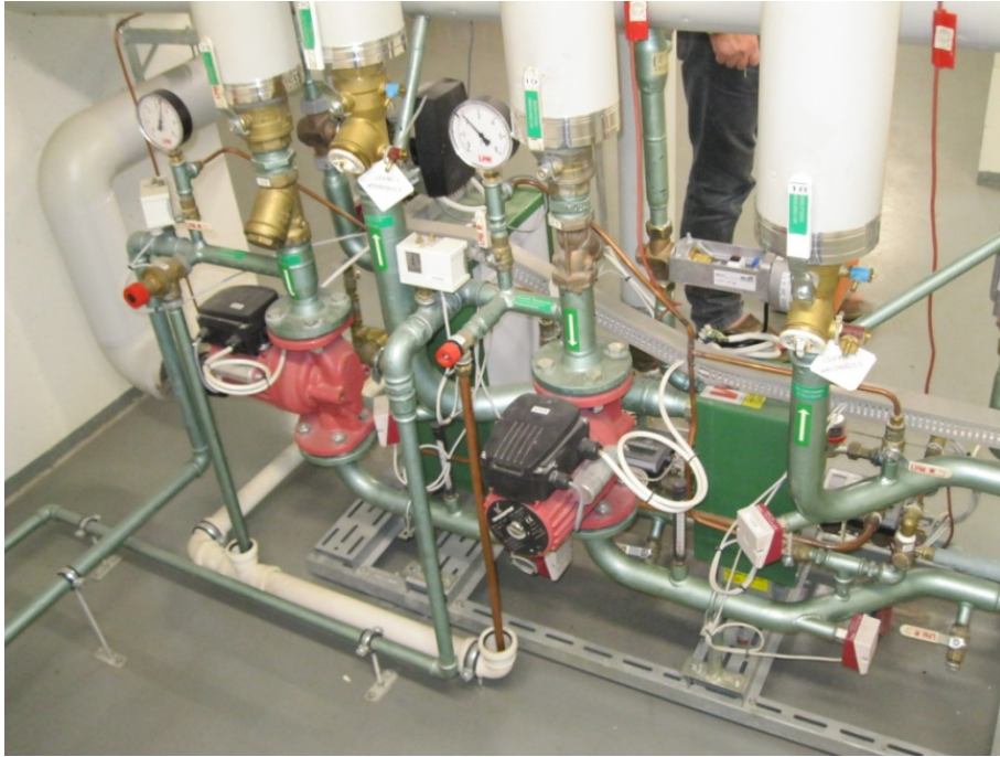
Joonis 10.2 Näide uuritud korruselamu sojussõlmest.
