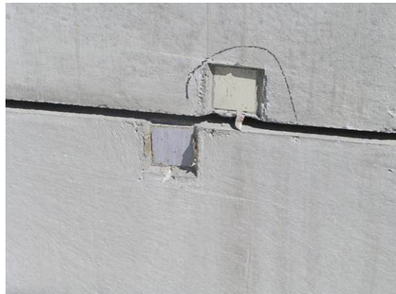
Joonis 3.4 Liiga paks tagastäitekiht, olemasolev pinnas dreniva liiva asemel (vasakul); valesti valmistatud seinapaneelid (paremal).
