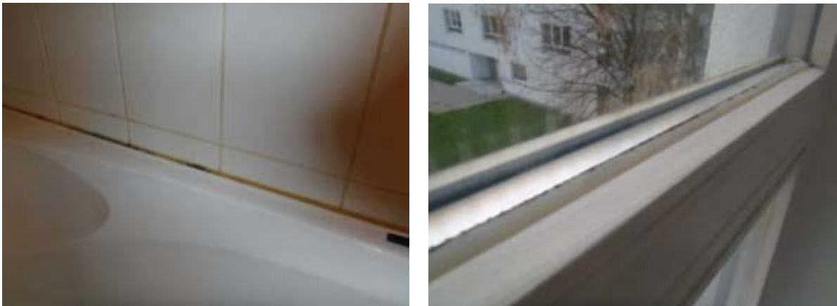
Joonis 13.2 Vanniserva tihendussilikoon on „mustaks“ tõmbunud. Seda ei ole võimalik puhastuskeemiaga kõrvaldada, vaid tuleb uuendada (vasakul). Akna klaaspaketi tihendamiseks kasutatud silikoon on kogu ulatuses hallitanud (paremal).
