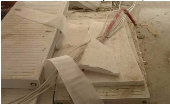
Joonis 3.1 Korras- ja hoolimatus ehitusplatsil kandub kahjustada saanud materjalide kaudu üle ka ehitisse ja mõjutab selle kestvust (nii otseselt kui ka kaudselt).
