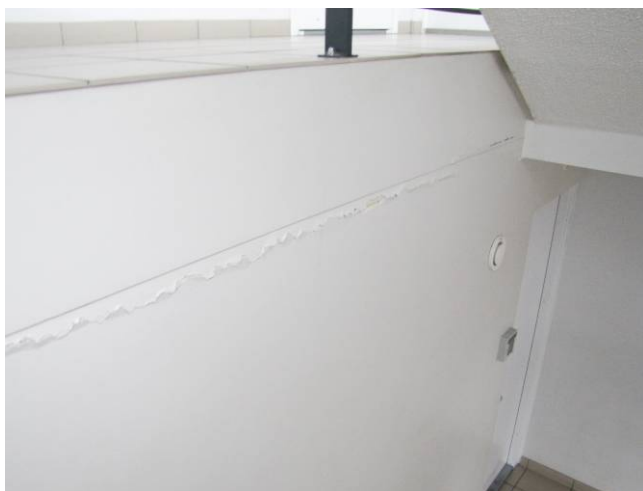
Joonis 5.42 Pragu materjalide liitekohas tulenevalt koormusest (vasakul) ja vajumispragu trepikoja ning korteri vahelises seinas mõjutab potentsiaalselt tarindi õhu- ja helipidavust ning tulepüsivust (tiheduskriteerium E).
