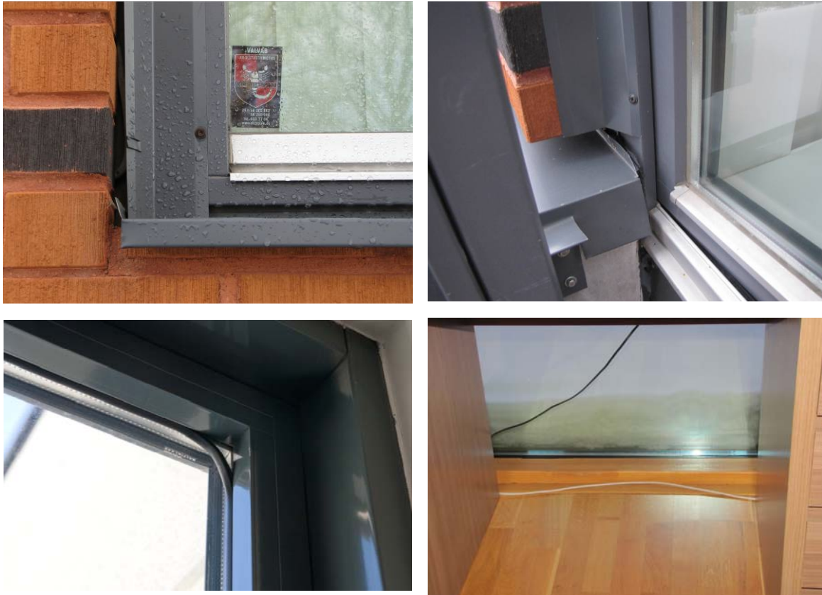
Joonis 5.39 Puudulikult tehtud avatäite ja seina liitekohad (üleväl), paketiilistu liigsed temperatuurideformatsioonid (all vasakul) ning maani ulatuv avatäide, kus plus temperatuurid klaasi välispinnal põhjustavad lume sulamist ja potentsiaalse veelekke tarindisse.
