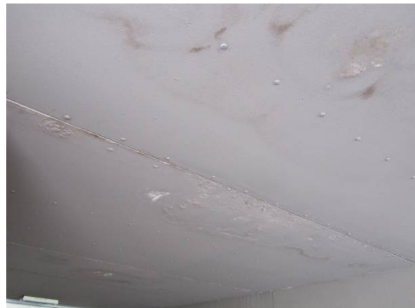
Joonis 5.21 Terrassi ebapiisava kalde (vasakul) ja katusekatte läbijooksu tõttu kahjustunud lagi (paremal).
