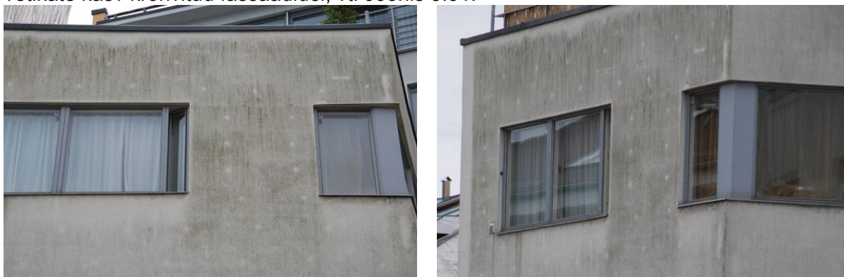
Joonis 5.31 Vetikakasv krohvitud komposiitsoojustusega fassaadil.
