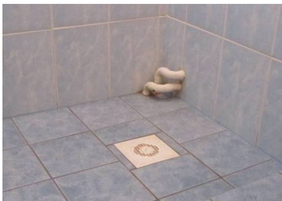
Joonis 5.43 Vasakul: välditavad läbiviigid märgade ruumide hüdroisolatsioonis on liigsete riskide allikaks. Paremäl: seina poole kaldu vanni serv ning kõrge niiskuskulisa soodustavad hallituse teket.
