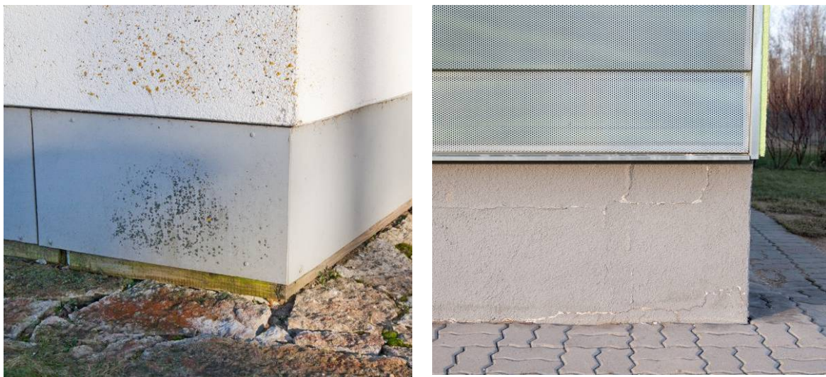
Joonis 5.8 Niiskunud laudroovitisega mittetuulutav tsementkiudplaadiga kaetud sokkel (vasakul). Krohvitud komposiitsoojustusega kaetud sokkel ei ole kauakestev lahendus (paremal).
