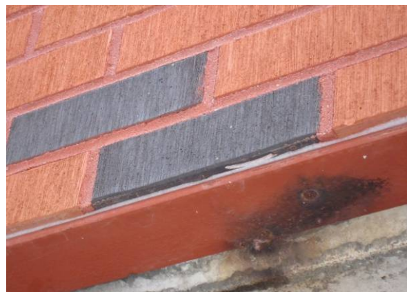
Joonis 5.26 Projekteerimis- ja ehitusvigadest põhjustatud deformatsioonid. Õnestellise eenduvast augureast põhjustatud külgnevate metallkonstruktsioonide roostetamine vee ja lume toimel.
