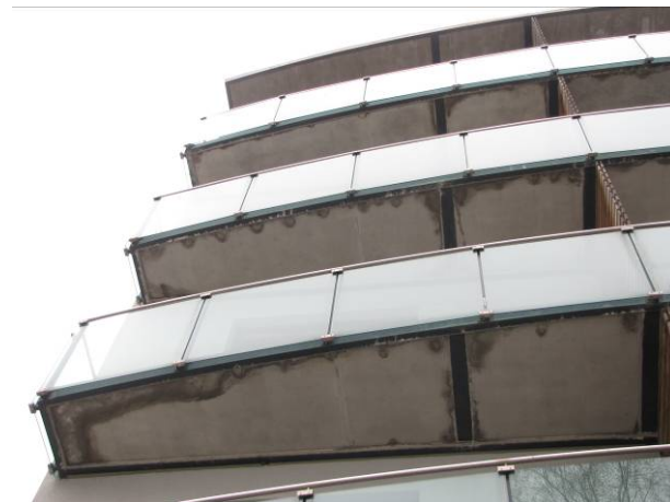
Joonis 5.22 Valesti lahendatud vee äravool rõdudelt märgab fassaadi ja põhjustab rõduplaadi korrosiooni.
