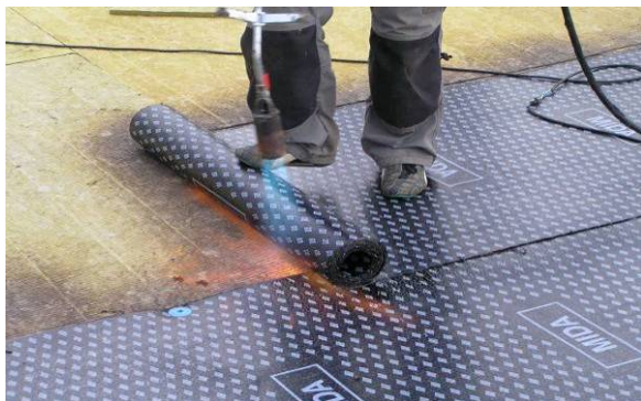
Joonis 3.16 SBS-katte keevitamine lamekatusele, kus soojustus ja kate tüübeldatakse läbi paani serva, kasutusel on impregneerimata pinnaga kõvavillplaat, küsimuseks jääb vettpidava külgülekatte laius (vasakul); kaldharjaga katusele, kus kelpkatustel puudub harja- ja otsaviilutuulutus (paremal).
