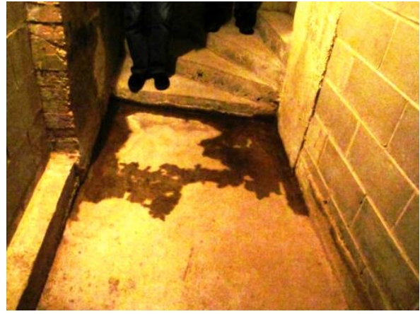
Joonis 5.4 Märg ja vett läbilaskev väikeplokk-sokkel ja märgjad põrandad hoone sees.
