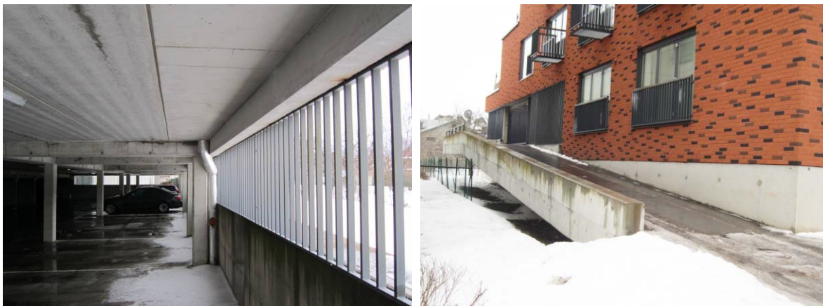
Joonis 5.1 Esimesel korrusel paikneva garaaži laes esinevad läbijooksud avatud terrasside, valitud materjalide, mittesobiva konstruktsiooni ja sadevee ärajuhtimissüsteemi tõttu (vasakul). Katmata pandus (paremal).
