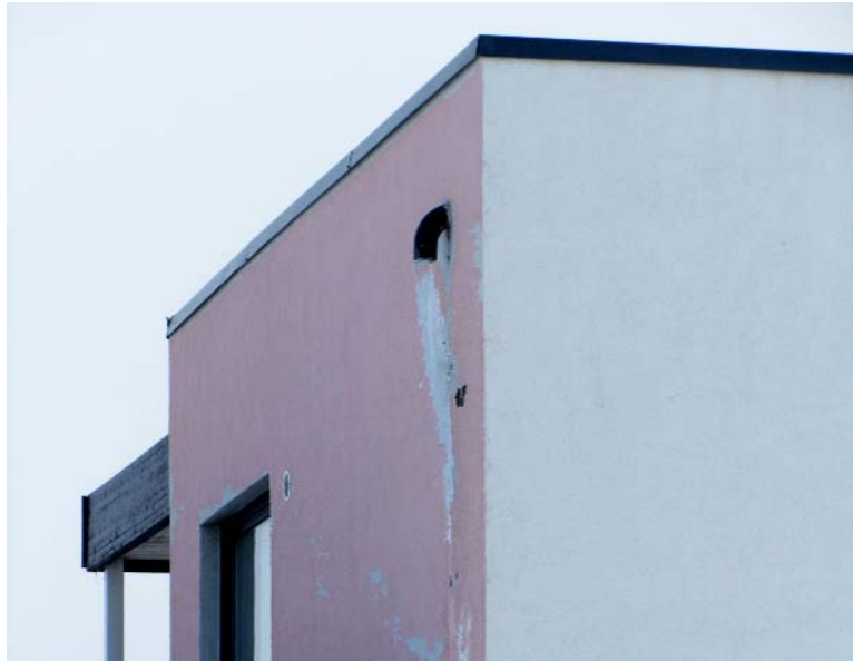
Joonis 5.18 Katuse sademevee äravoolusüsteemi puudumise tõttu valgub katuselt kokkukogutud vesi fassaadile.
