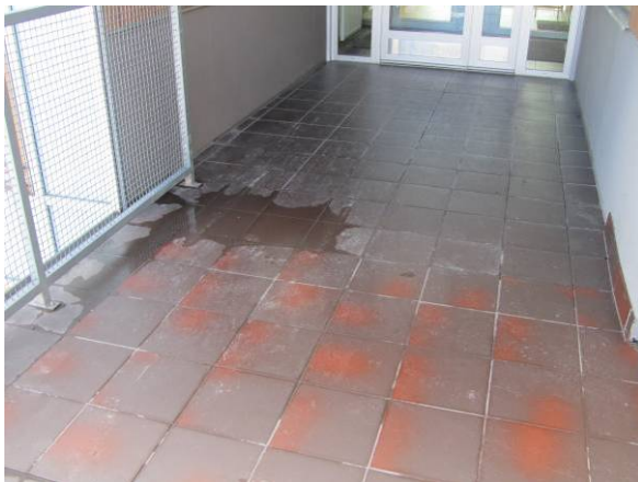
Joonis 5.21 Terrassi ebapiisava kalde (vasakul) ja katusekatte läbijooksu tõttu kahjustunud lagi (paremal).
