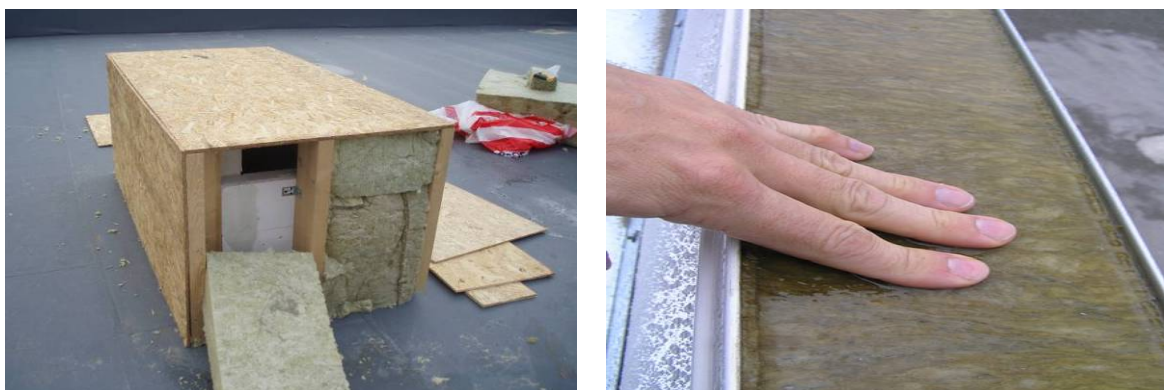
Joonis 3.14 Tehnošahti ots korruselamu katusel ehitati erinevalt katuse põhilahendusest ilma aurutõkketa, kasutati sügavimmutamata puitu, kaheldavaid kinnitulahendusi ja materjal ei vasta šahtile ettenähtud tuletõkestusklassile (vasakul); märjaks saanud soojustus ei tohi jääda tarindisse, vaid tuleb asendada uue ja kuivaga (paremal)
