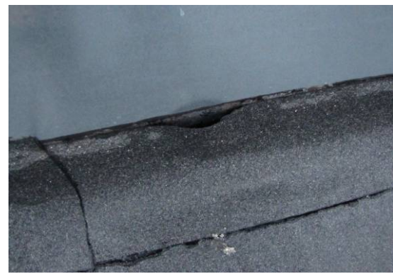
Joonis 5.14 Korrektselt lõpetamata katusekatte ülespööre vertikaalpinnale (vasakul) ning kinnituspinnast irdunud katusekate (paremal).
