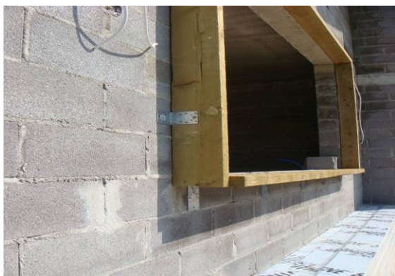
Joonis 3.17 Prussraam avatäite paigalduseks pole projekteeritud, vaid kohapeal ehitaja poolt lahendatud kinnitused (vasakul); üllatused pörandakatte paigaldusel: aken ei käi lahti (paremal).
