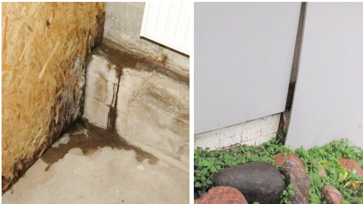
Joonis 5.7 Keldrisse tunginud vesi põhjustab puitlaastplaadil lagunemist (vasakul). Soklit kattev tsementkiudplaat on deformeerunud ja osaliselt mulde all (paremal).
